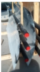
Echangeur de chaleur avant mise en place dans la canalisation
